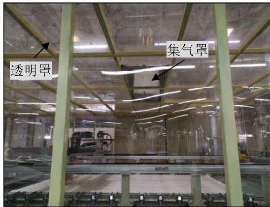
芯材板切断收尘装置
