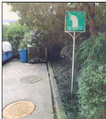
厂区的生化池
