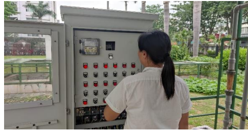
1. 污水操作工進行污水廠設施設備巡檢
