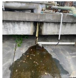
4. 發現4號雨水總口積水原因為B棟樓頂冷卻塔漏水；
